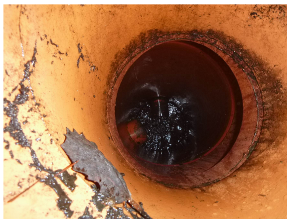
Dokumentované průsaky vody skalní stěnou a jejich podchycení drenáží v patě svahu u ocelové haly
